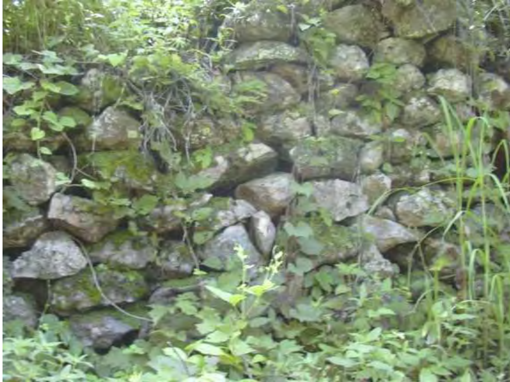
Figura 9. Muro de terraza en Yichkuhuan.
